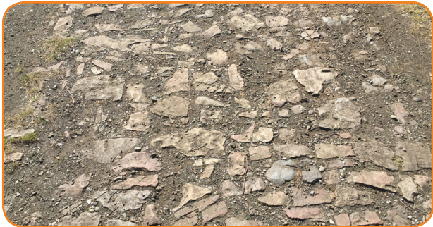
Anciens pavages de la voie ferrée
