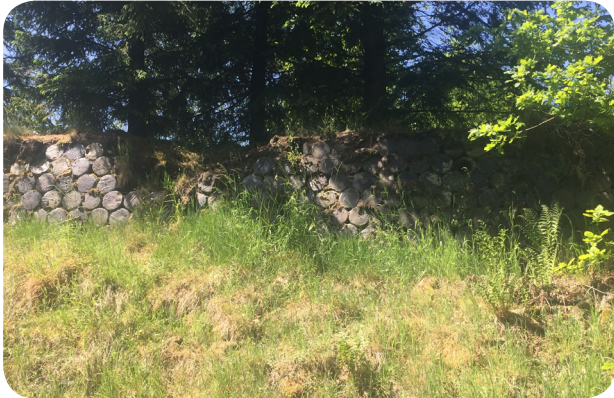
Mur en culots de fonderie
